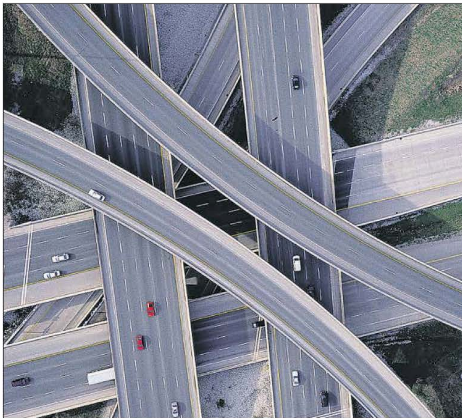
Autopista 407 ETR, en Canadá. EE
