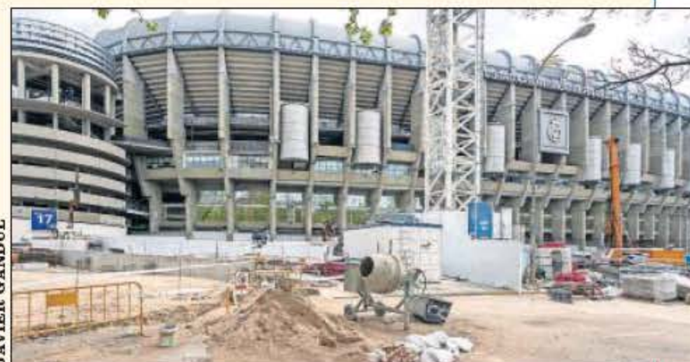
Imagen de ayer con las obras exteriores del Bernabéu paradas.
