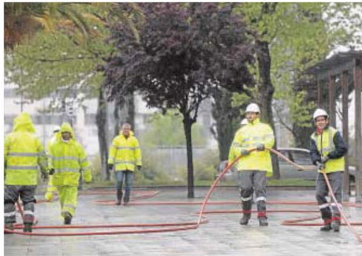
Reanudación de unas obras en Torrejón (Madrid)
